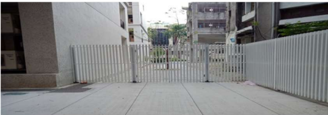
同慶路校園美感改善工程完工照片
