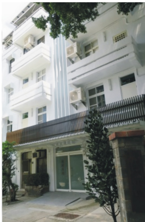
▲和平一路110巷眷舍重新整建為藝創基地
