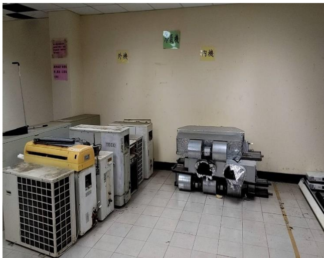
照片 3 冷氣機內外機
