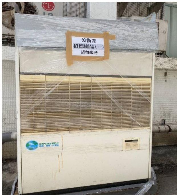
【照片 3】藝術學院外走廊-冷氣機
