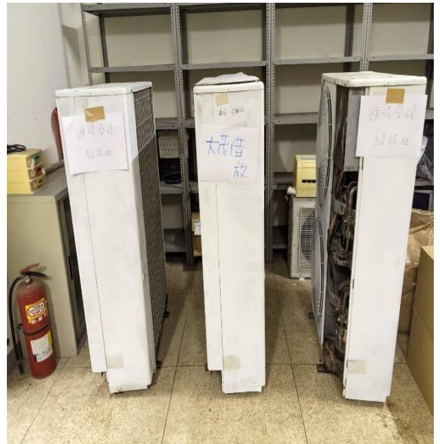
【照片 2】行政大樓 B1-三台大型冷氣機外機
