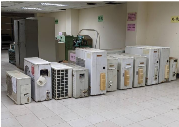
照片 5 冷氣機(外機)
