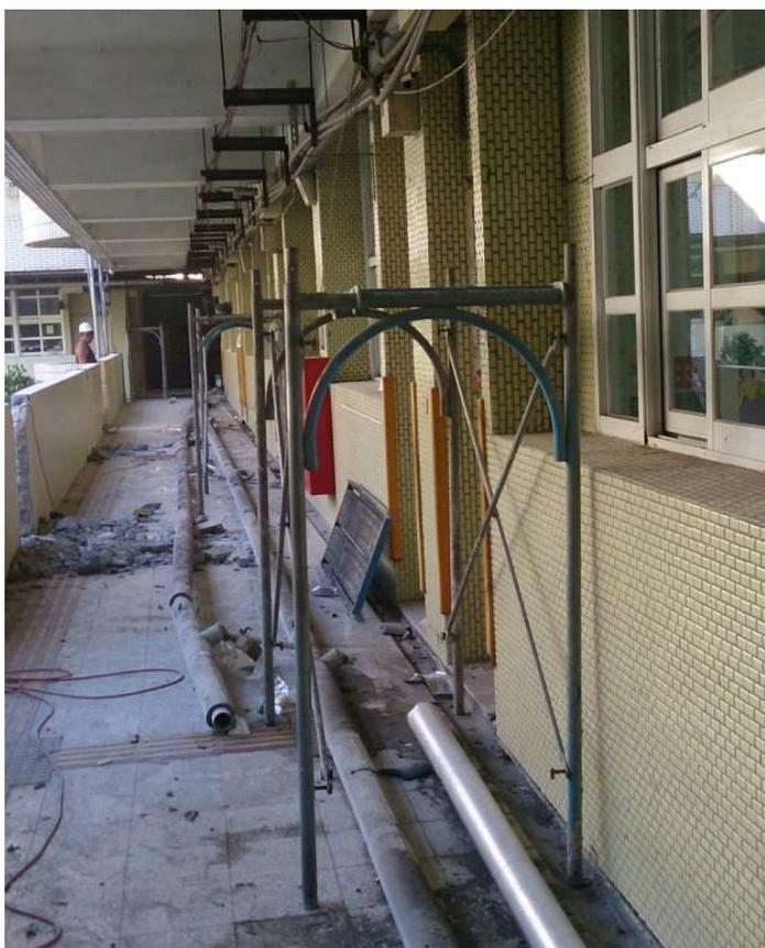
105年某學校校舍耐震能力補強工程施工人員，於施工架切割冷氣管線，切割作業未設置防止物體飛落之設備，致管線飛落砸傷工人，2人送醫。
