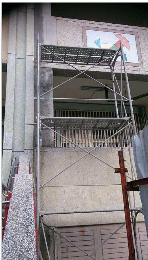
105年學校校舍耐震能力補強工程施工人員自2公尺以上施工架跌落受傷住院。
