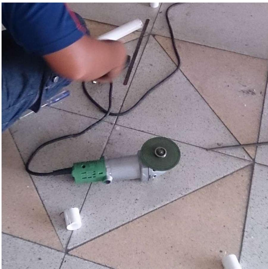
105年學校宿舍修繕工程使用未設置護罩之手持式電動砂輪機作業。
