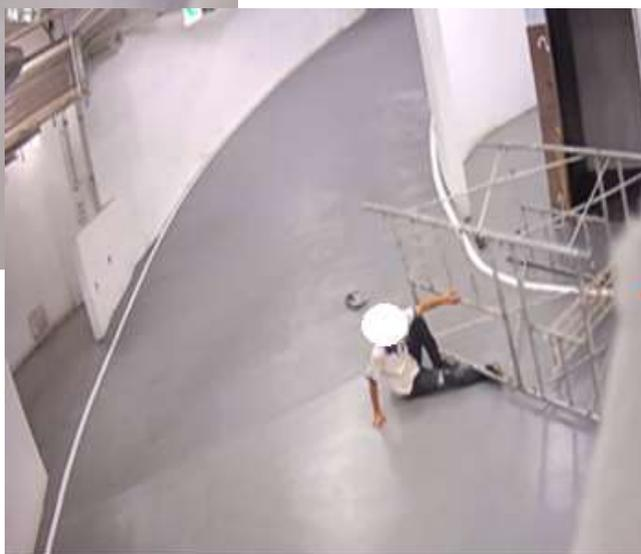
107年11月21日，罹災者在地下室斜坡車道，立於移動式施工架上從事天花板補漆作業，另名同事負責扶住移動式施工架。在移機作業時，罹災者未依規定先離開施工架，且因於下坡移動難以控制，腳輪因車道高差往低處滑動，導致罹災者連同施工架翻倒，經送醫不治。
