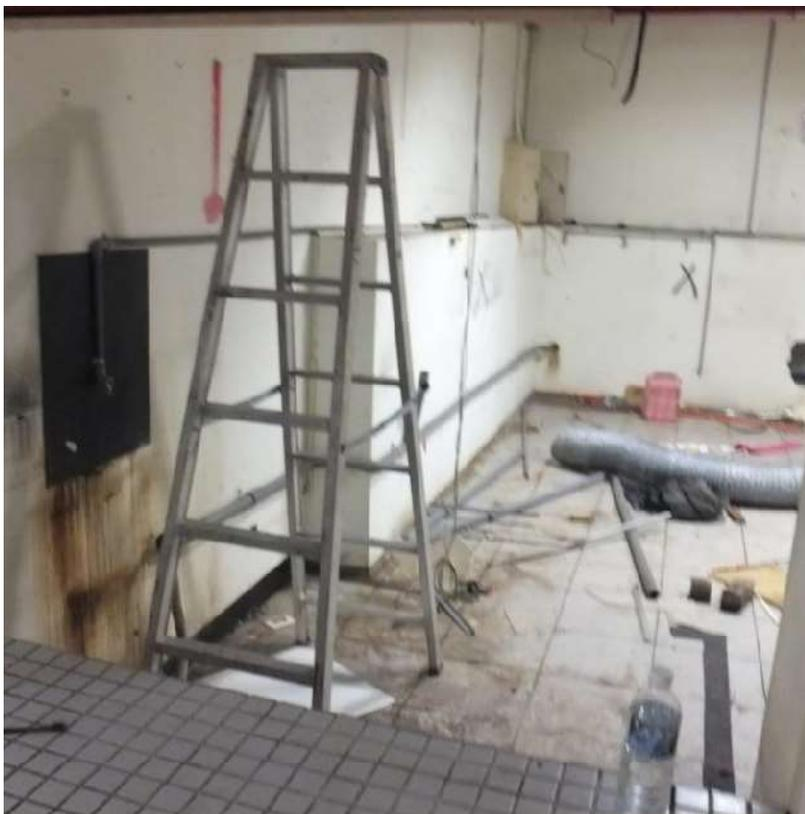
106年7月3日，學校拆除作業承攬商再承攬人勞工，於學生餐廳使用合梯從事輕鋼架天花板拆除作業，疑因地板油汙未清除，致鞋底沾有油汙，攀爬合梯至第三階時滑落，致左小腿骨折受傷。
