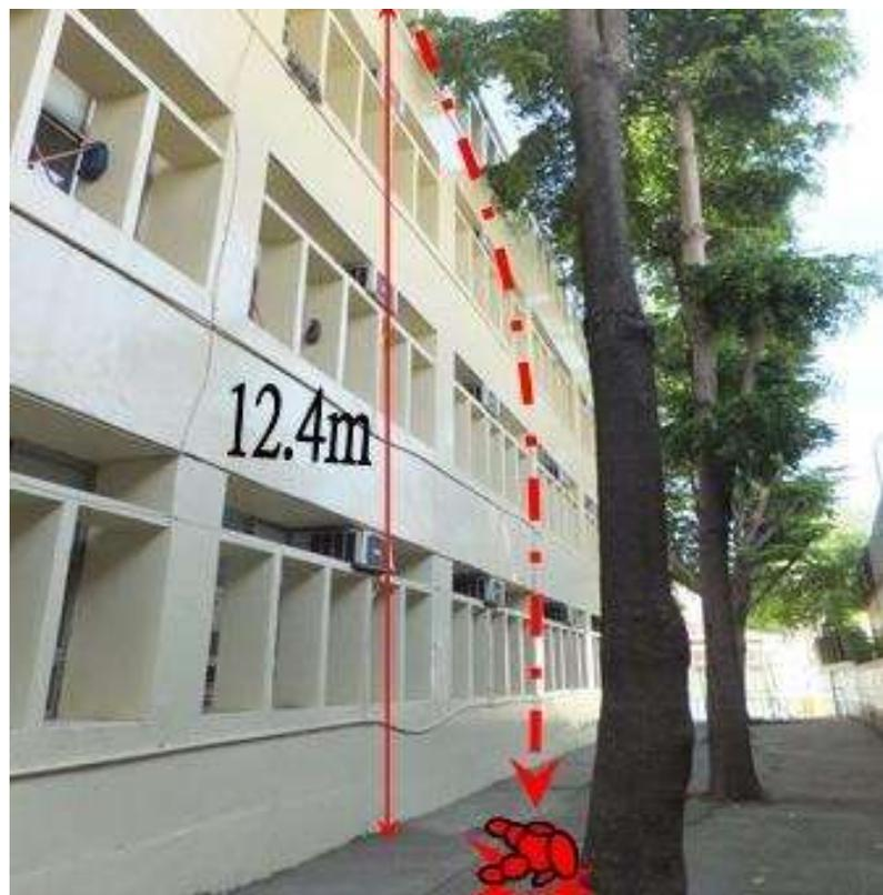
104年6月14日，某學校窗型冷氣清洗維護，承攬商爬上4樓窗台欲將冷氣由外往教室內推動拆下時，自離地面高度約12.4公尺墜落地面死亡。
