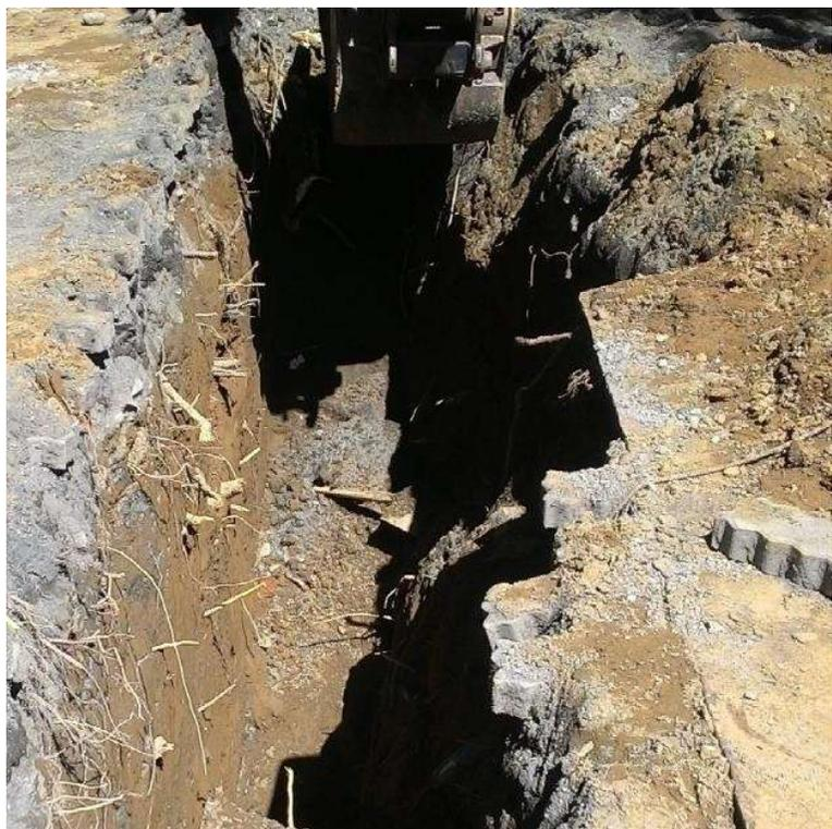
105年9月10日，學校校內污水下水道接管及排水溝修繕工程，承攬人於垂直開挖深度約2.8公尺管溝內從事接管作業，因未設置擋土支撐，勞工遭開挖面之土石崩塌掩埋，送醫不治。
