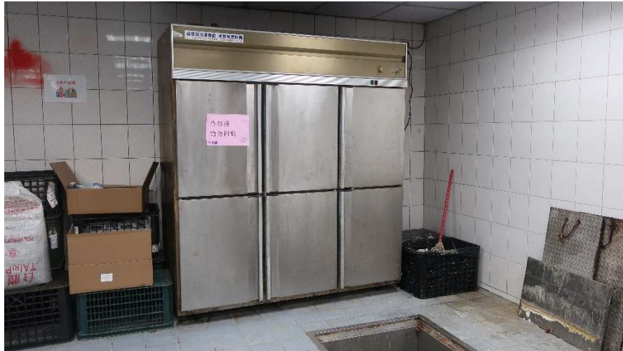
【照片五】冷凍櫃(地下室)
