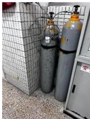
▲鋼瓶未確實固定及已逾有效期限
