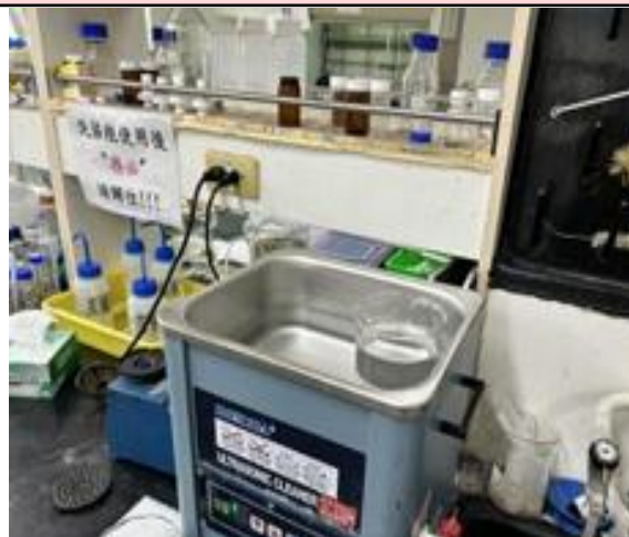
▲潮濕場所之電器設備未裝漏電斷路器
