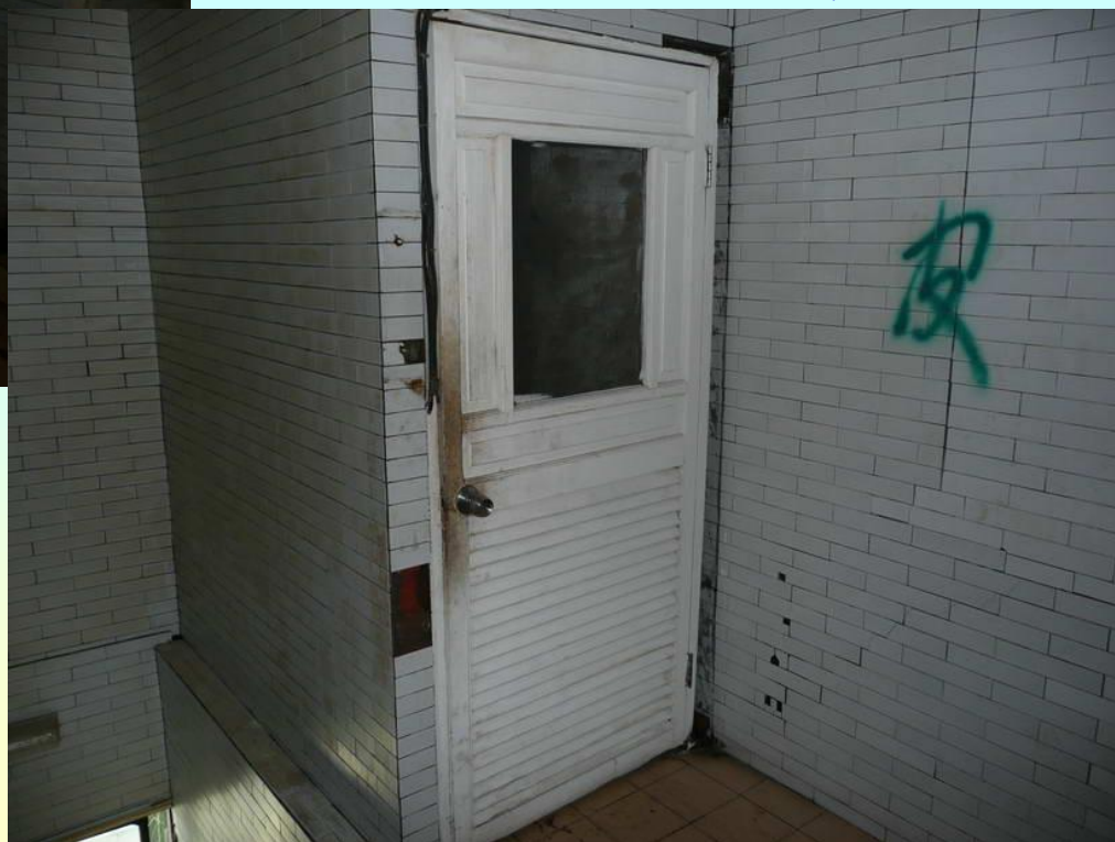
3樓貨梯口及 其木製拉門
