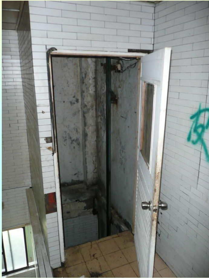
3樓貨梯口及其木製拉門
